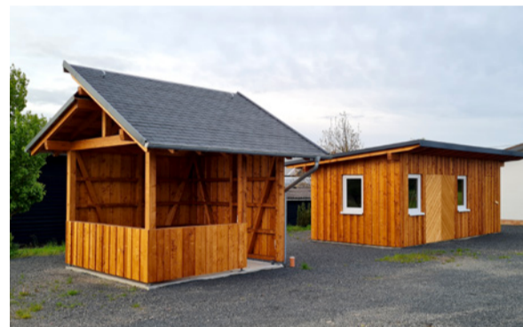
Der TV Gösenroth 1909 e.V. konnte dank der Förderung eine Schutzhütte mit Grillstelle am Freizeitgelände Gösenroth errichten.
